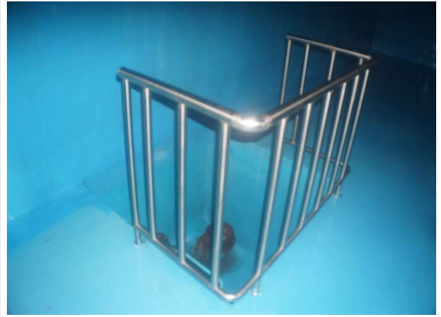
항내 집수정 진입 사다리 상태양호
