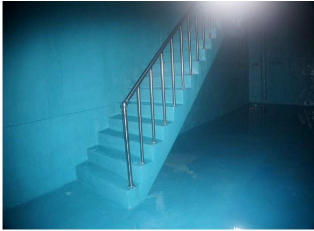
배수지 내부 안전난간 상태양호
