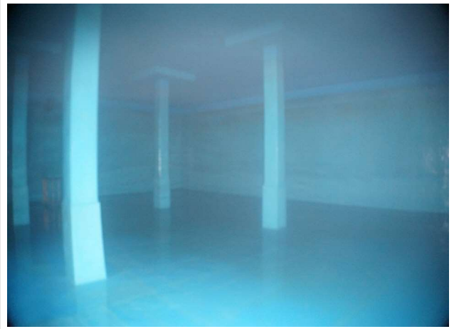
배수지 내부 전경
