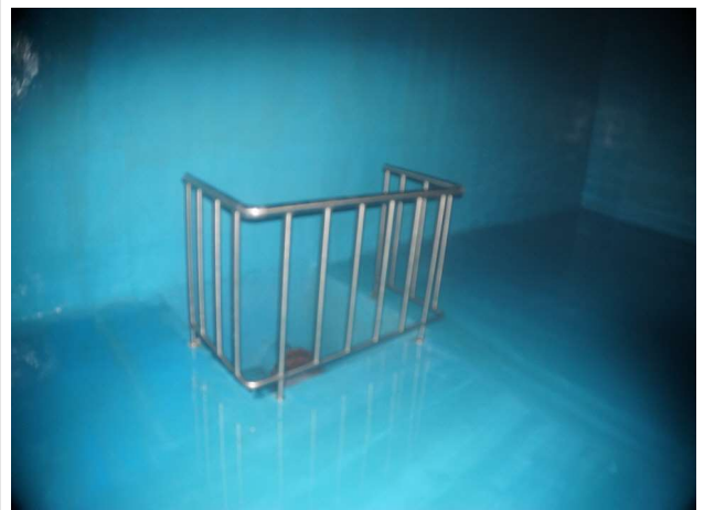
배수지 1지 안전난간 상태양호
