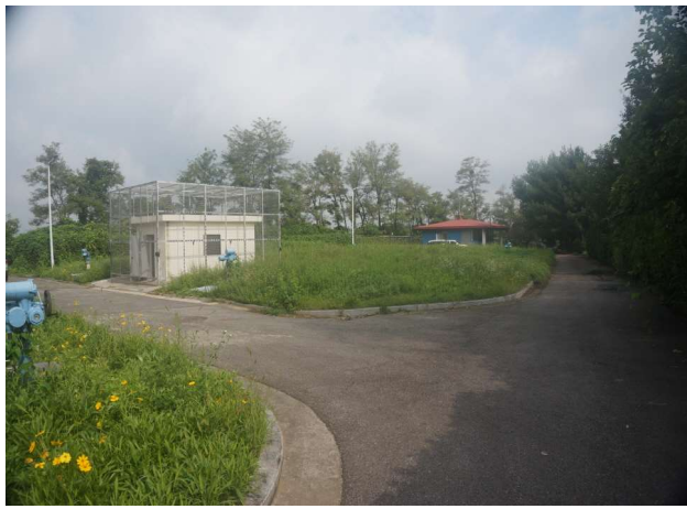
배수지 외부 전경
