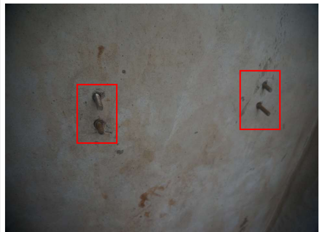
유입밸브실2지 상부슬래브 앵커존치
