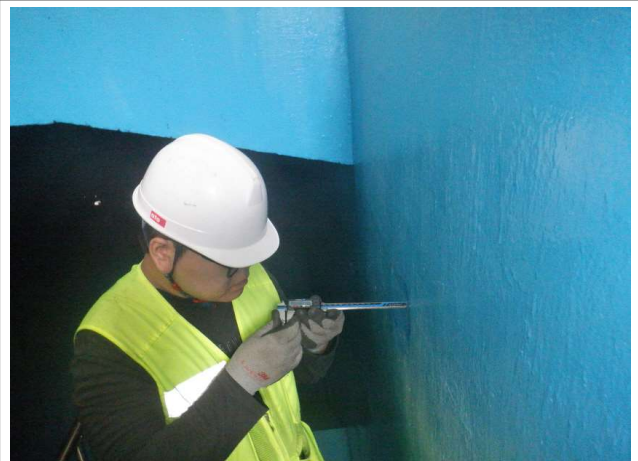
탄산화 깊이 측정
