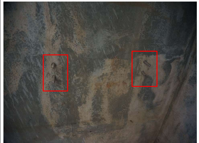
유입밸브실1지 상부슬래브 앵커존치
